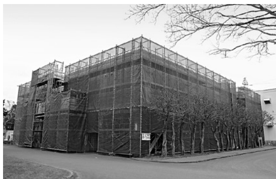
外壁塗装工事の様子
